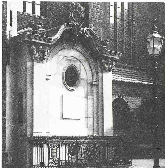
Grabkapelle Schindler in Barockgestalt von 1737 mit reich gestaltetem Ziergitter, Hauptgesims mit Rollwerk und Gesimsaufsätzen
