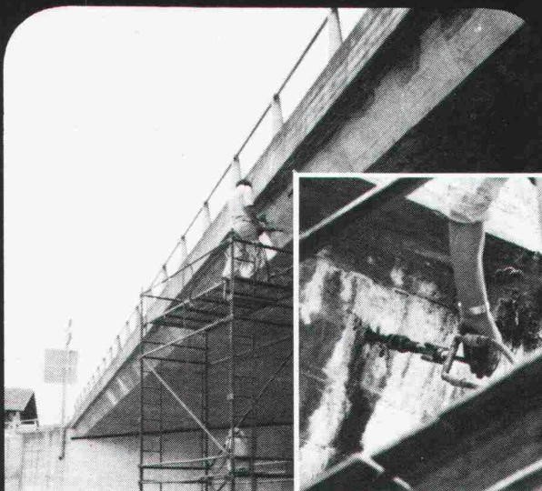
Risse in Betonbauwerken Abdichtung mit Renesco-Flexin-Injektionen
