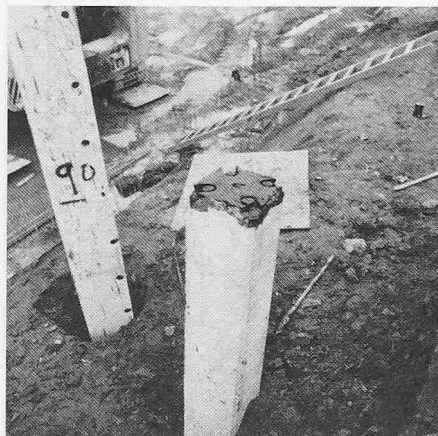
Bild 6. Unterer Pfahlschuss eingerammt
