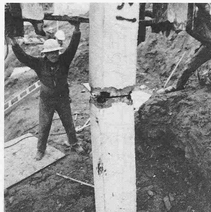
Bild 7. Aufsetzen des oberen Pfahlschusses
