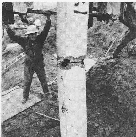
Bild 7. Aufsetzen des oberen Pfahlschusses
