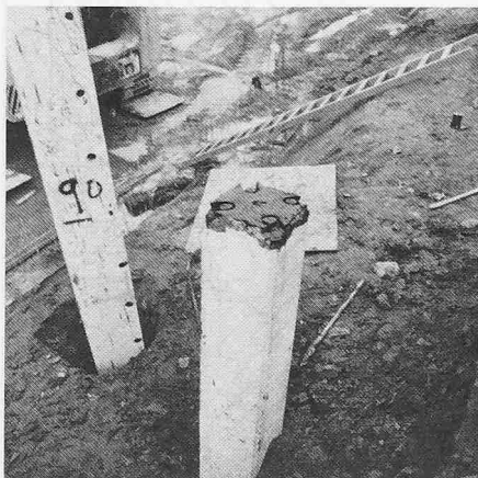
Bild 6. Unterer Pfahlschuss eingerammt
