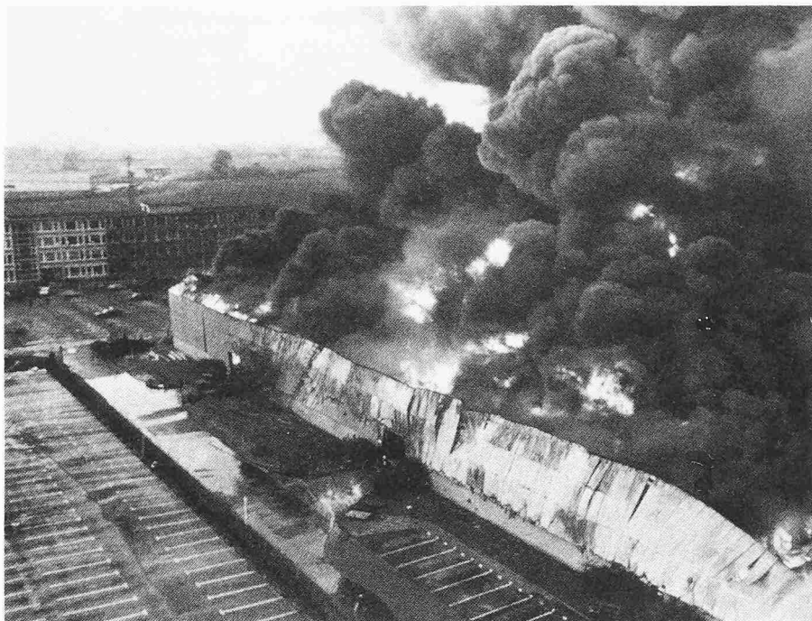
Am Donnerstag, dem 20. Oktober 1977, wurde das zentrale Ersatzteillager der Ford-Werke AG in Köln-Merkenich durch Feuer vollständig vernichtet
