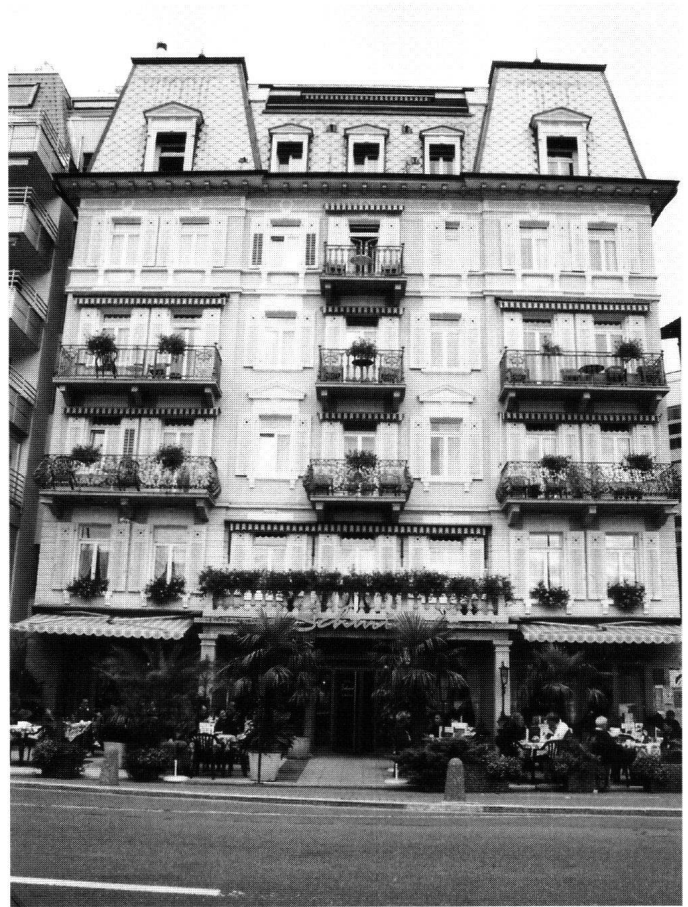
Abb. 3: Ingenbohl, Hotel Schmid, Axenstrasse 5, Brunnen. Der Hotelbau der Jahrhundertwende setzt an der Quaianlage von Brunnen dank der anhand des Befundes rekonstruierten Farbfassung einen starken Akzent.
