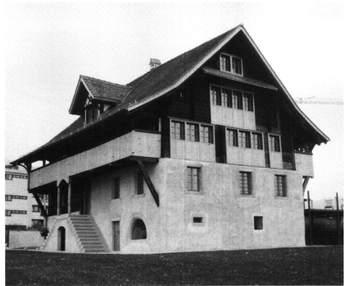
Abb. 6: Altendorf, Haus Steinegger, Hafenweg 2. Die 1518 datierte rundbogige Öffnung gehört zum ältesten Bauteil des Gebäudes, der 1577 sowohl in seiner Grundfläche wie in den Obergeschossen wesentlich erweitert worden ist.
