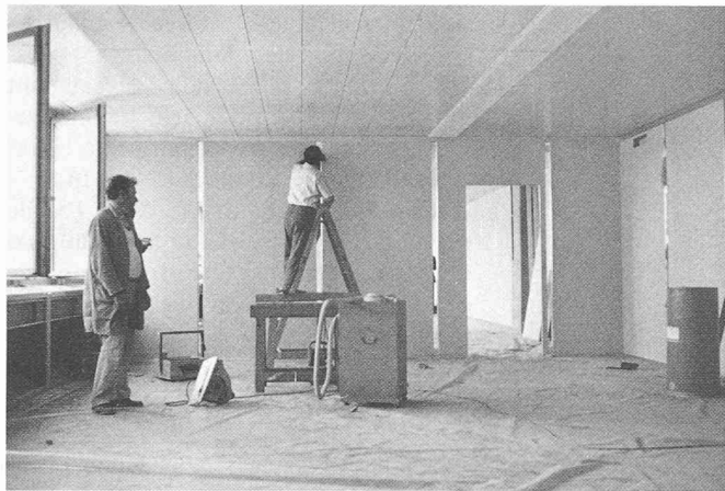
Fig. 10. — Montage des cloisons mobiles.
