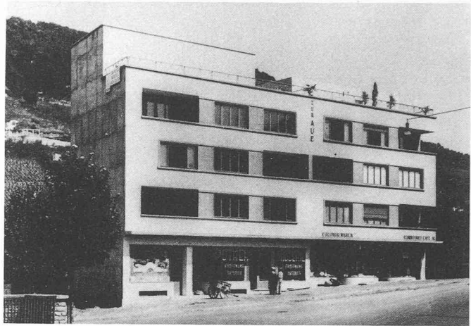
Fig. 14. — Immeuble «Zur Aue».
