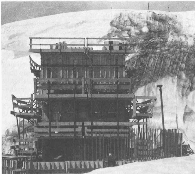
Bild 12. Rohbau Juni 1982: Schalen und Armieren am 2. Untergeschoss und am aufstrebenden Liftturm. Im Hintergrund die Schneewächte vom Chli Titlis
