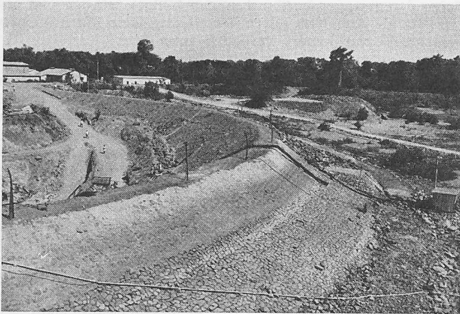
Bild 10. Unterwasserseitiger Fangdamm während der Niederwasserperiode im April 1961
