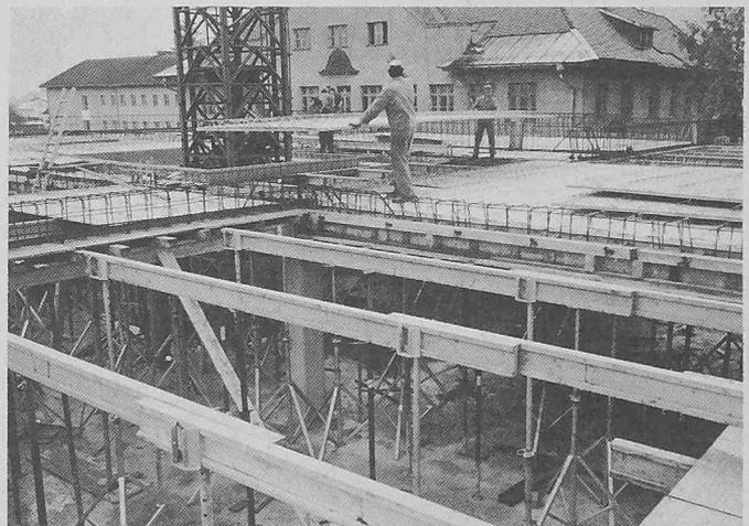
Bild 1. Fertigteildecken mit System Dokaflex 20
