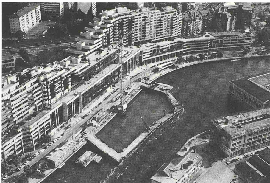
Bild 3. Bau des neuen Regulierwehres in der Rhone in Genf
