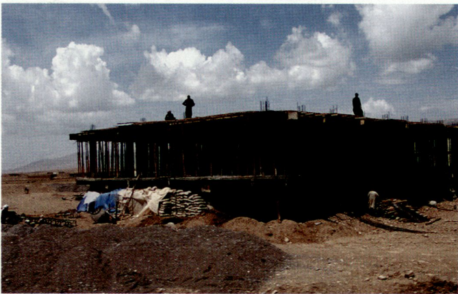
Häuserbau in der Provinz Loghar.
