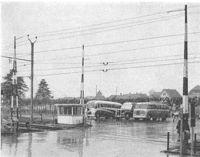
Bild 2. Übergang 3 (Unterseen). Man erkennt drei der vier vorhandenen Barrieren-Antriebe; alle in geöffneter Lage. In der Bildmitte ist der Wärterposten ersichtlich, von dem aus die Barrieren dieses Überganges bei starkem Strassenverkehr bedient werden
