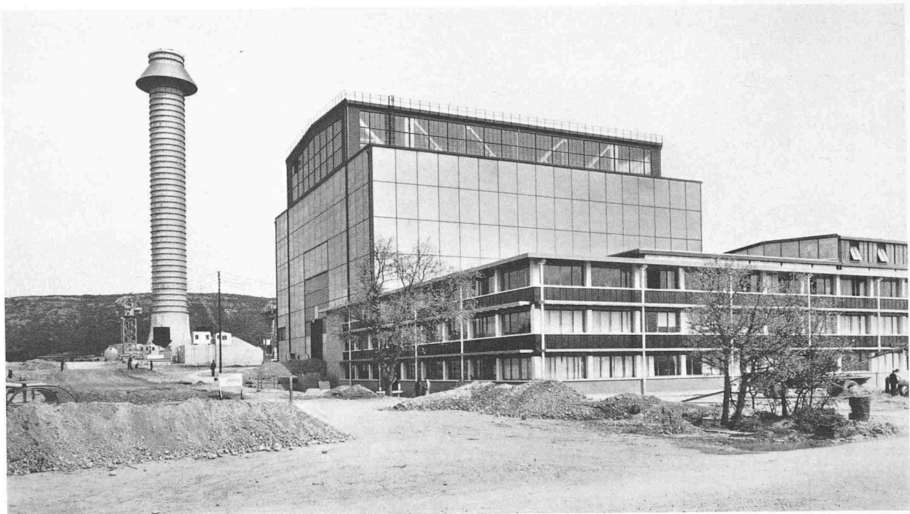
Bild 7. Das Gebäude des Reaktors G_1 , davor die Gebäude für die Hilfsanlagen, links der Hochkamin von 100 m Höhe.
