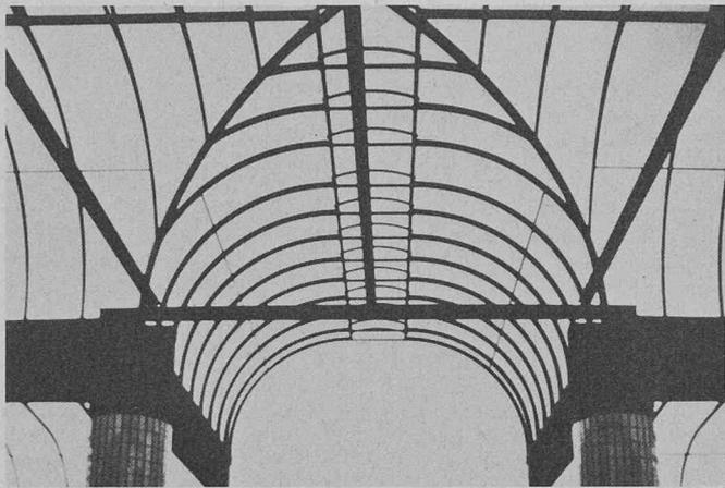
lonnage, assure la compression nécessaire des garnitures assurant l'étanchéité, et autorise cependant les dilatations ou les contractions du vitrage. Les plaques, épaisses de 5 mm, mesurent 5,20 m x 0,982 m et pèsent 30 kg. Cela représente un poids de 10 tonnes pour l'ensemble des 350 plaques couvrant les 1600 m<sup>2</sup> de la Galerie marchande. Le montage des ces plaques est rapide: une équipe de 3 personnes monte en moyenne 9 à 10 plaques par jour.
