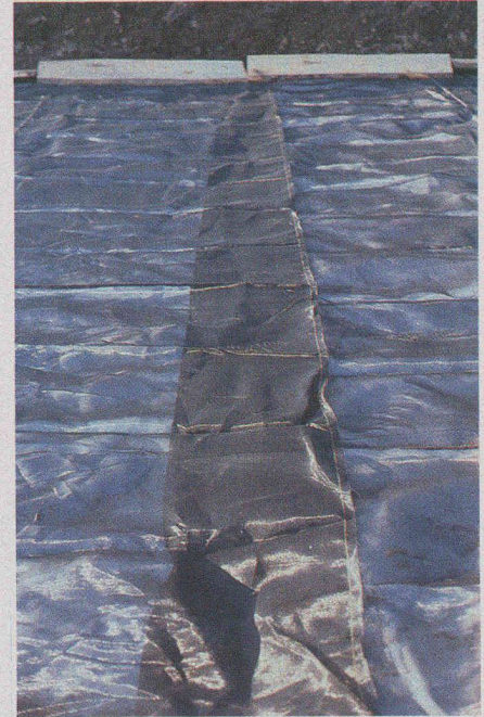
Fig. 14. — Recouvrement des laizes (tissé).
