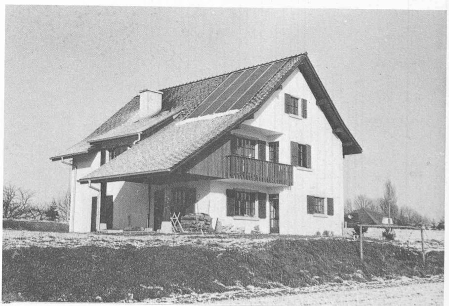
Fig. 1. — Façades sud-est et sud-ouest.
