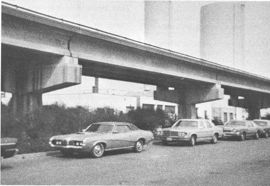
Fig. 3. — Vue d'une travée complète du viaduc de Collingswood.
