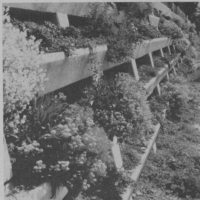
Detail aus einer bepflanzten Stützmauer
