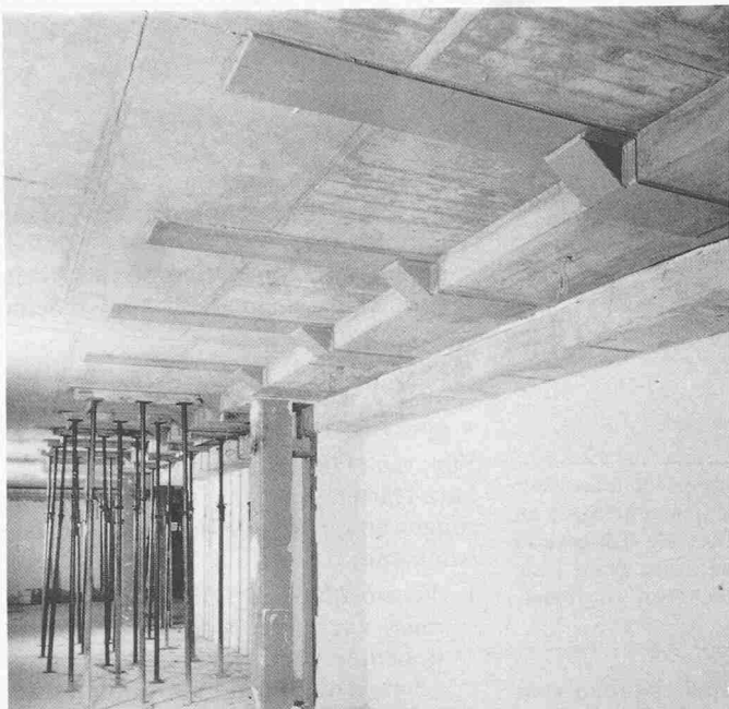
Bild 2. Die durch den nachträglichen Einbau einer Klimaanlage notwendig gewordenen Klebarmierung vor dem Ausfräsen der Deckendurchbrüche
