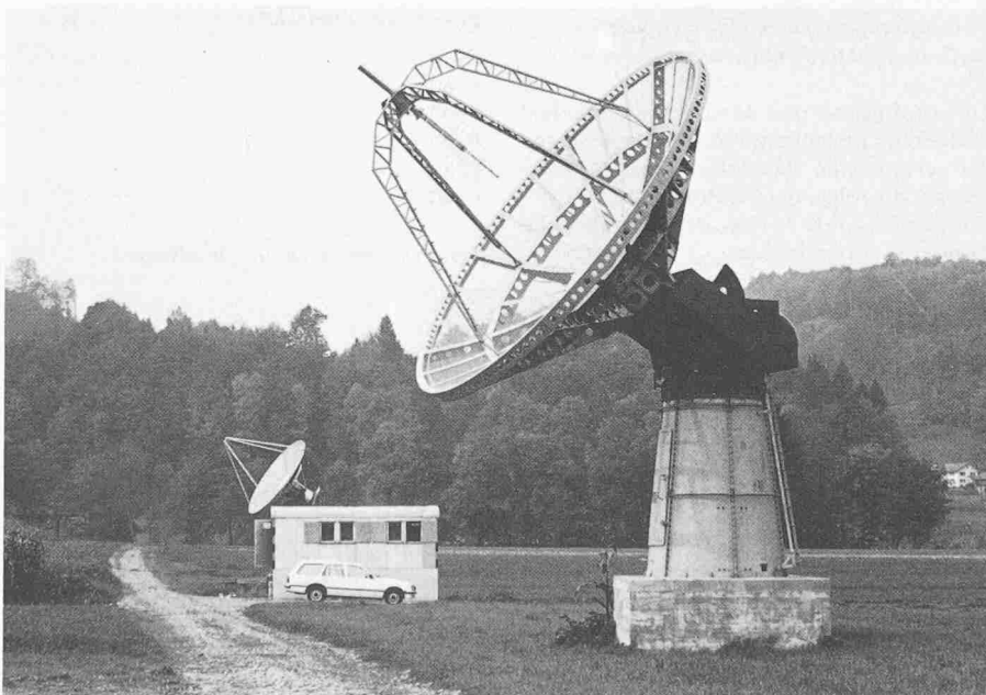
Die Antennenanlage bei Bleien/Gränichen (AG), rechts der Strecke Suhr-Luzern
