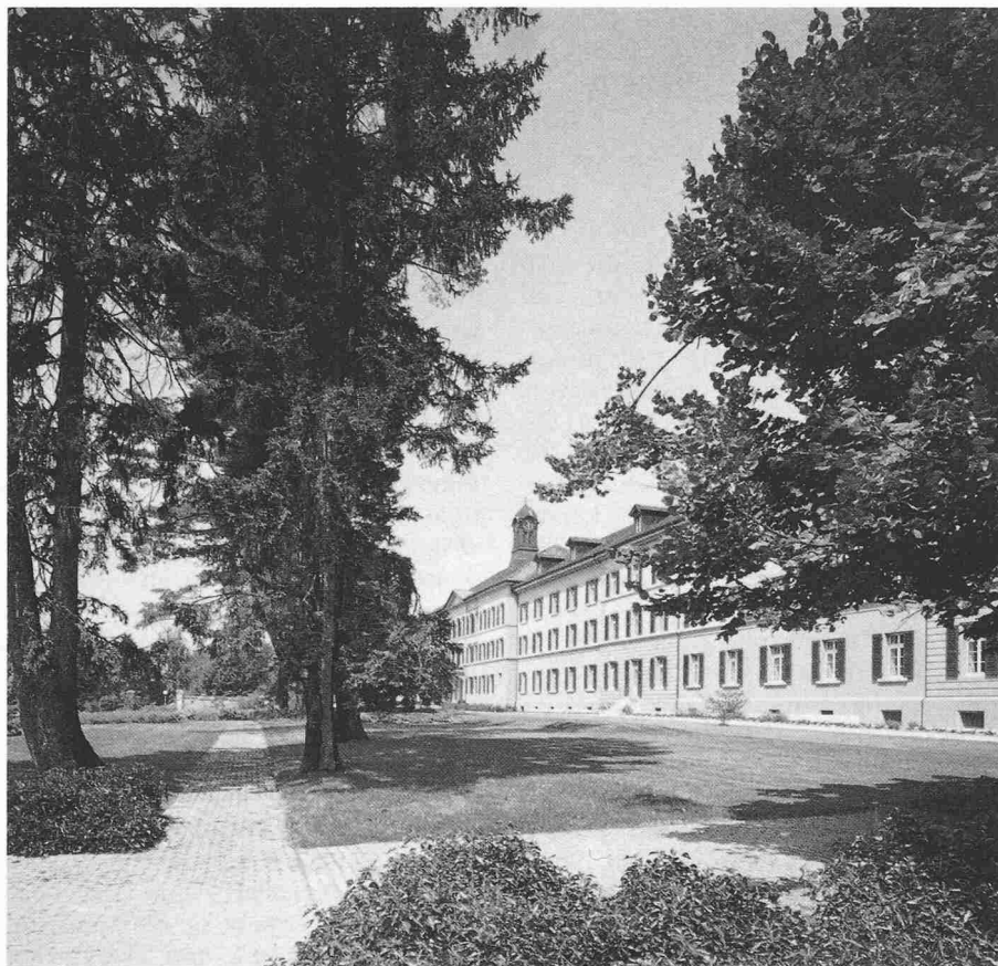
Ausschnitt Südfassade Ostteil
