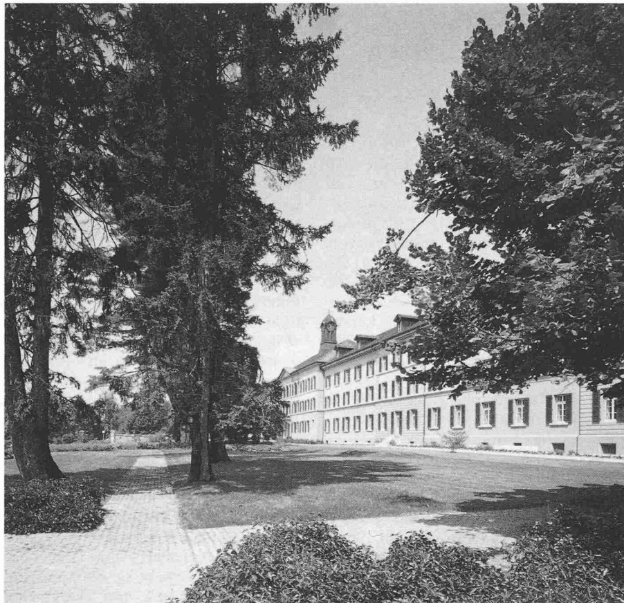
Ausschnitt Südfassade Ostteil
