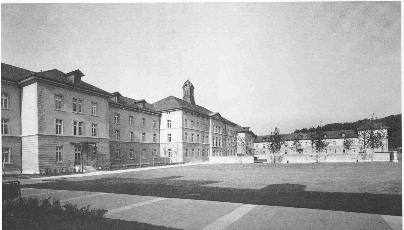
Nördlicher, U-förmig umschlossener Hof
