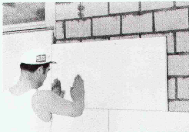
System K: Hartschaumplatten vesetzt auf Mauerwerk kleben.
