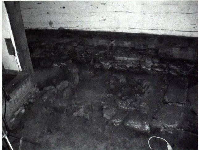
Abb. 46. Oberägeri ZG, Grubenstrasse 37. Runde Feuerstelle aus dem 16. Jh. im Zusammenhang mit einer rechteckigen, herdähnlichen Konstruktion entlang der nördlichen Blockwand. Ganz rechts Reste des originalen Bretterbodens. Foto KA ZG, Ch. Muntwyler.
