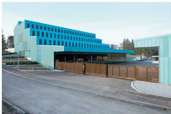
Betriebsgebäude IBB, Brugg
