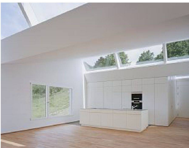
Über 4 Meter Raumhöhe unter den Sheddächern
