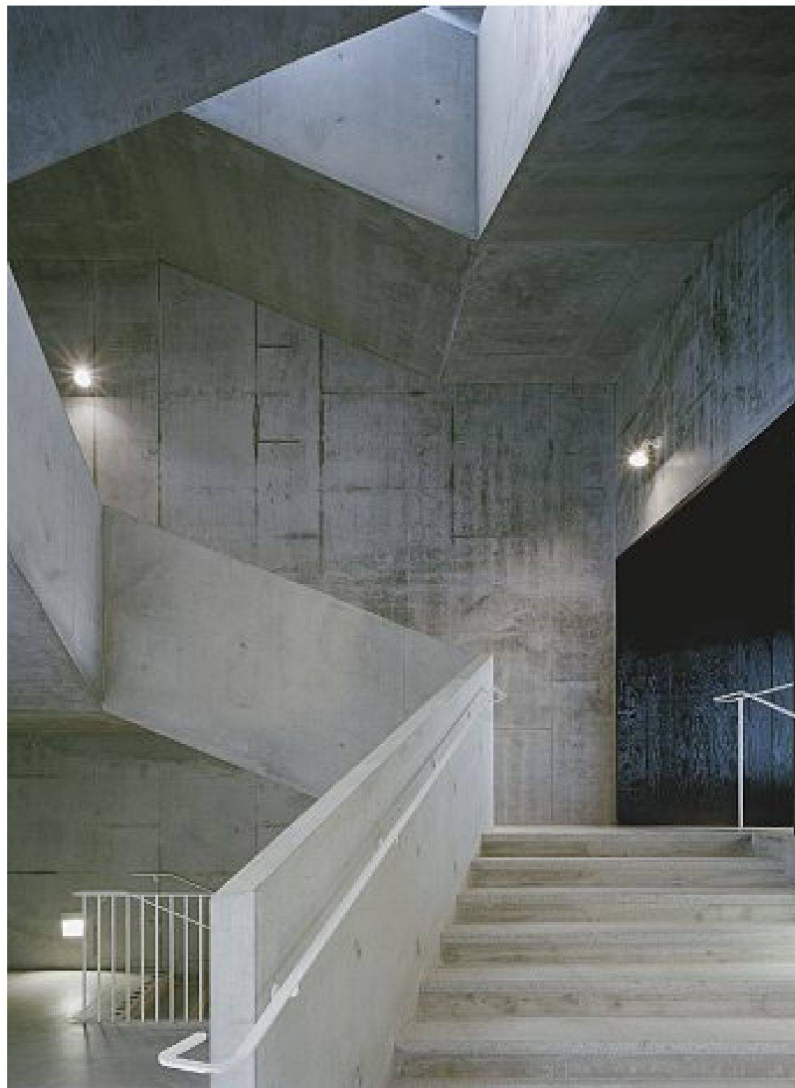
Die Treppe besteht aus einem Stück und hat keine Dilatationsfugen.
