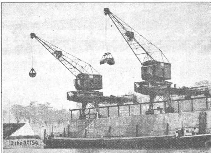
Hafenkrane für Greifer- und Stückgutbetrieb. Rheinhafen Kleinhüningen Basel.
