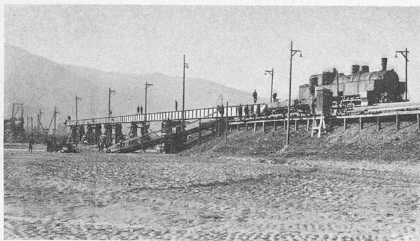
Abb. 11. Vorschieben der S. B. B.-Träger durch Lokomotive.
