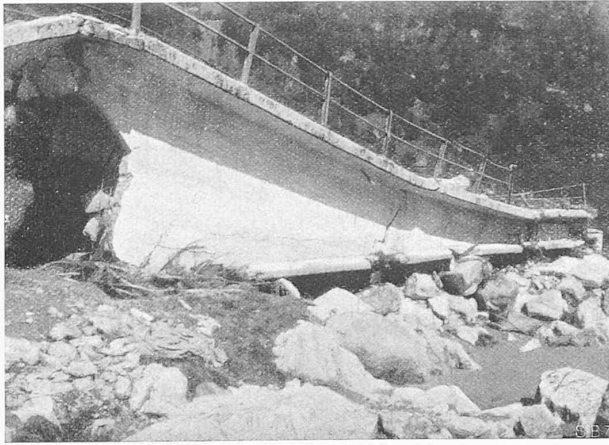
Abb. 10. Linke Brückenhälfte (III), flussaufwärtige Seite.
