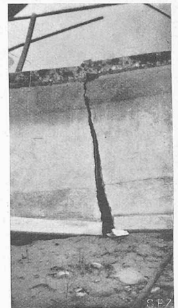
Abb. 12. Auf rund 2 m Höhe glatt durchgehende Bruchfuge (vergl. obige Abb. 11).
