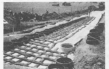
gründen erzielt. Das kompakte unverrottbare Bauelement kann rasch und ohne grossen maschinellen Aufwand eingesetzt werden. Nach dem Aushub wird das Terram-Kunststoffvlies verlegt, darauf die Autopneuteile ausgelegt und miteinander verbunden oder verflochten und bereits kann die Kofferrung erfolgen und der Teerbelag eingebaut werden.
