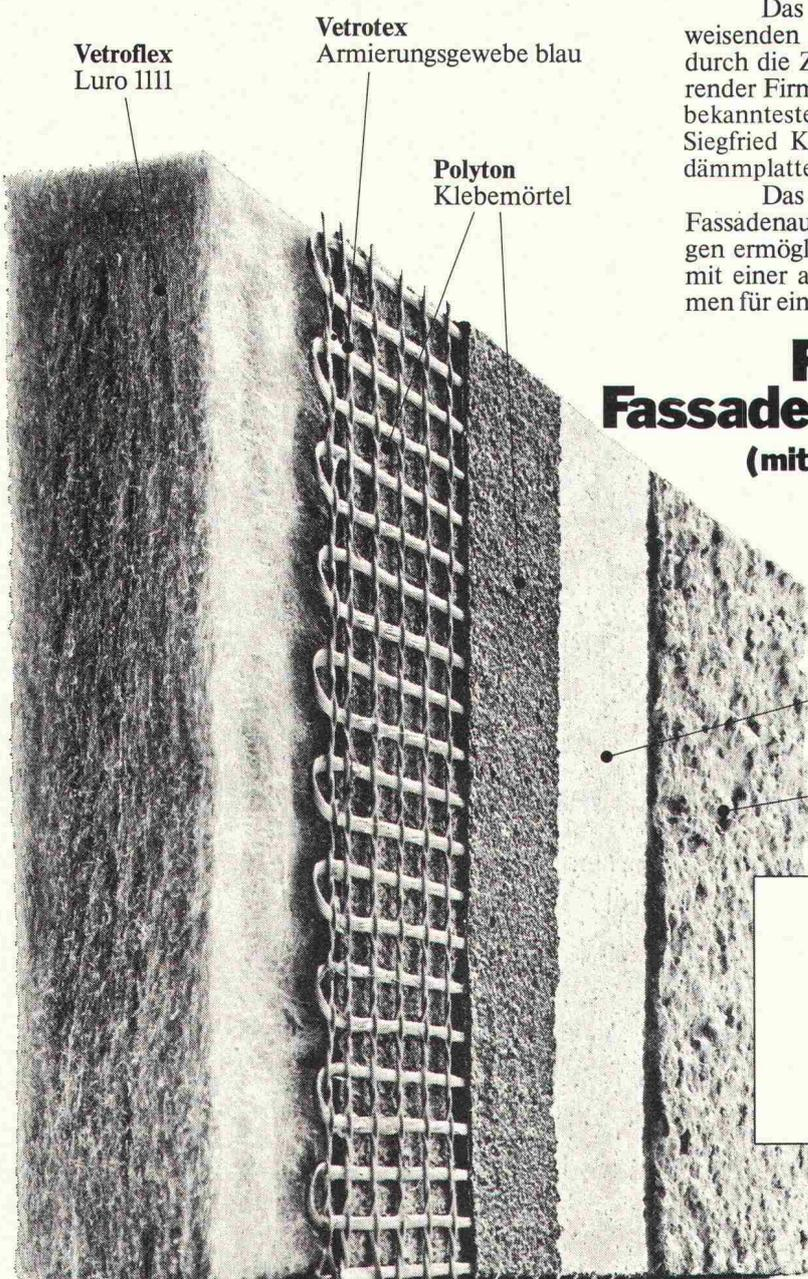
Das ist der gemeinsame Nenner eines zukunftsweisenden Fassadenaussendämm-Systems. Ermöglicht durch die Zusammenarbeit zweier im Baugewerbe führender Firmen. Und durch eine Kombination zwei ihrer bekanntesten Produkte: POLYTON-Putzaufbau der Siegfried Keller AG und VETROFLEX-Luro 1111 Wärmedämmplatten von Fibriver.
