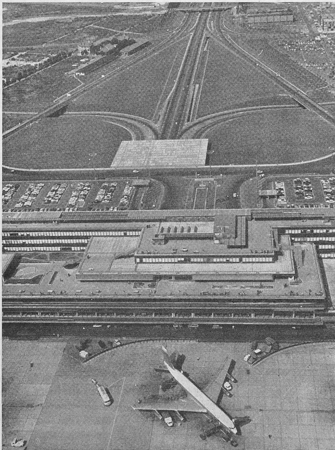
Fliegerbild des Flughafes Orly. Mittelteil des Gebäudes, vorn Standplätze, hinten Parkplätze und Zufahrten. Hinter dem Flugzeug ist die bogenförmig aufgestellte Abschirmwand sichtbar, in der Mitte der oberen Bildhälfte die N 7, welche unter die Bauten taucht
