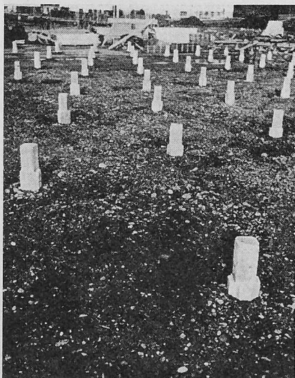
Bild 7, Pfahlköpfe nach Versetzen der Pfähle
