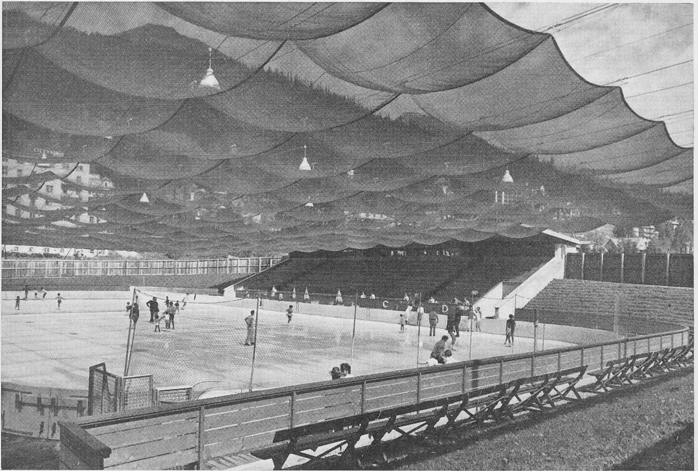
Bild 9. Die Kunsteisbahn Davos im Sommer, mit Sonnenschutznetz
