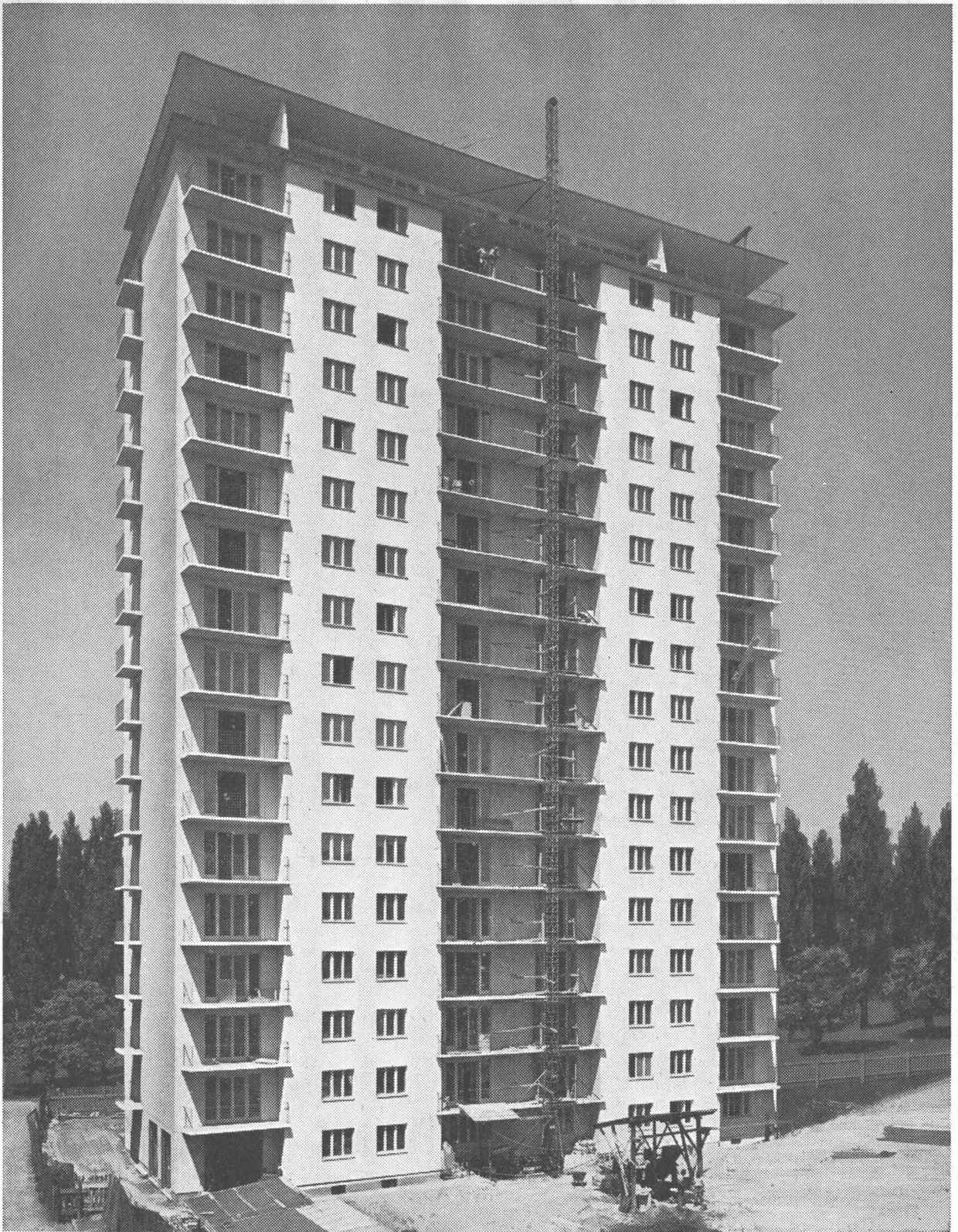
18-geschossiges Hochhaus in Graz, ausgeführt in Durisol-Mauerwerk
