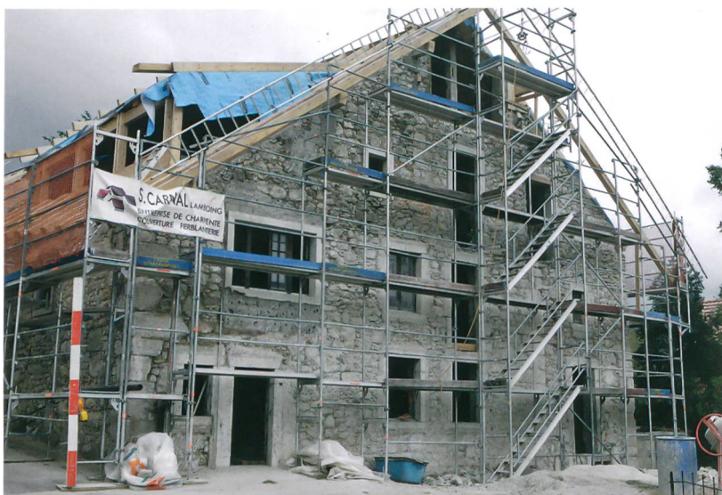
Fig. 1 : Plateau de Diesse, Lamboing, Les Moulins 1. Travaux de rénovation en cours. Vue vers le nord-est.
