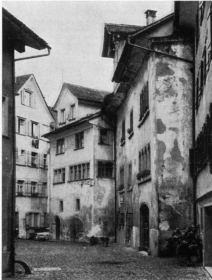
Abb. 1. Lichtensteig. Altes Rathaus, Zustand vor der Restaurierung
