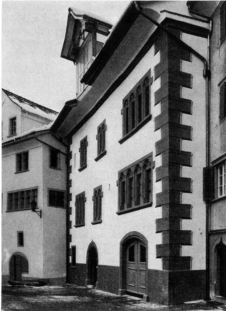
Abb. 2. Lichtensteig. Altes Rathaus, nach der Restaurierung von 1968
