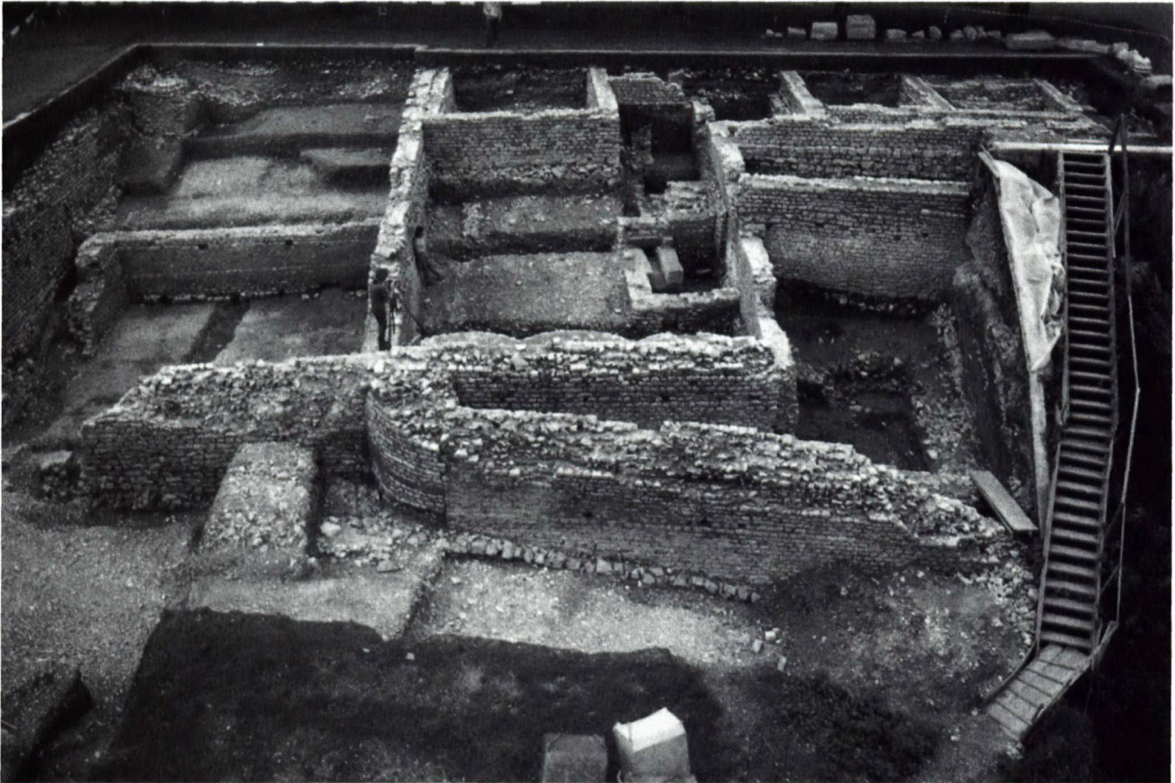
Abb. 8. Die Untersuchung und gegebenenfalls auch die Sanierung römischer Baudenkmäler erfordert Bauforschung. Augst, Insulae 1 und 2, Ansicht der mächtigen mehrphasigen Mauern bei Abschluss der Untersuchungen 1991/92 von Norden. Foto Römerstadt Augusta Raurica, Germaine Sandoz.
