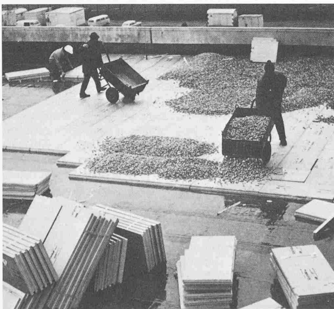
Aufbringen der Styrodurplatten und Bekiesung
