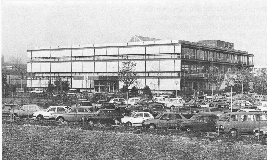
Bild 2. Südwestfassade mit geschlossenen Storen vor den Laufstegen
