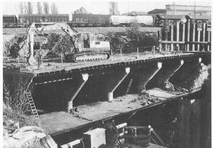
Bild 19 (unten). Einpress-tunnel von Bild 18 nach dem Durchstich
