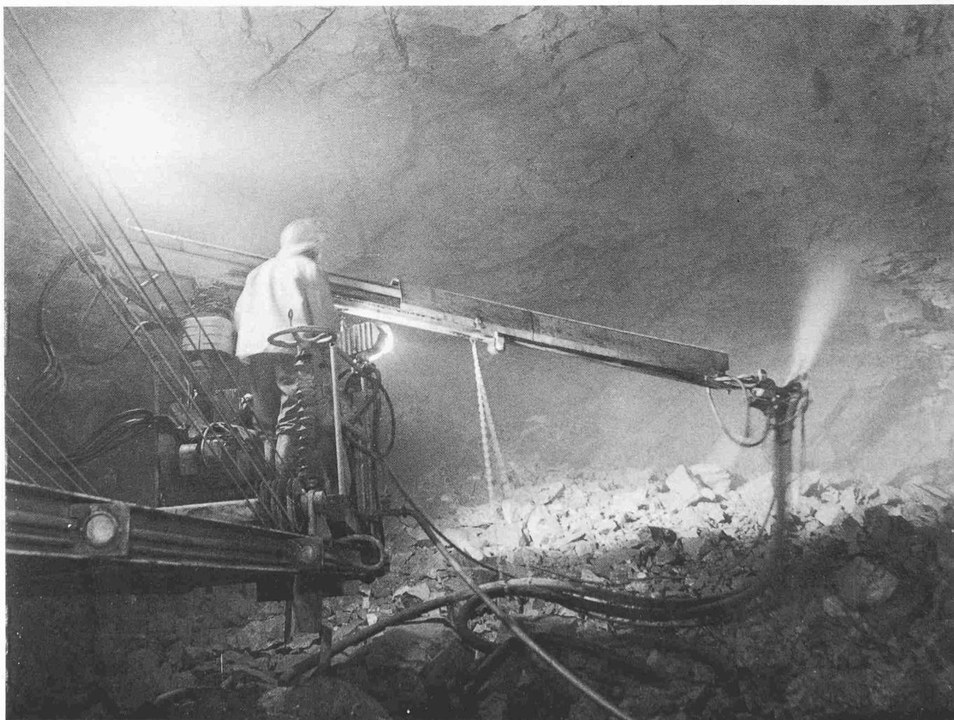
Bild 1. Spritzbeton-Roboter bei der Vortriebssicherung (Aufnahme Stabilator AB, Stockholm)
