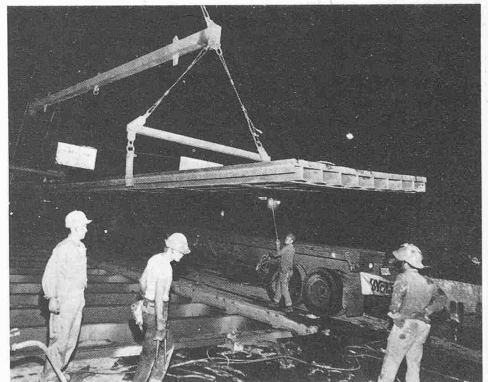
Der Einbau der verstärkten Stahlplatten mit dem Fahrbahnbelag erfolgt in Einheiten von ca. 3×18 m
