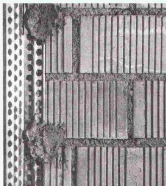
Dämmputzprofile für Ecken, Sockel, Dehnungsfugen usw. befestigen
