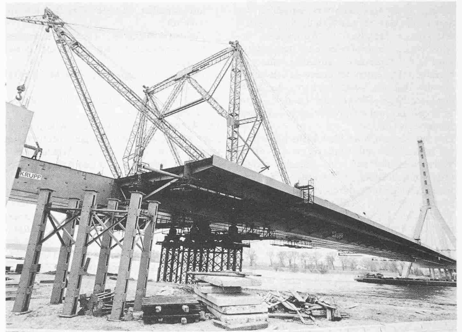
Mit dem Einfügen des letzten Schusses hat die Rheinbrücke bei Düsseldorf-Flehe das andere Ufer erreicht.
