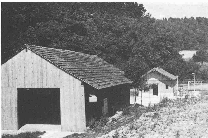
Die alte Sägerei im Vordergrund wurde mit der ARA als Gemeindegazin instandgestellt.
