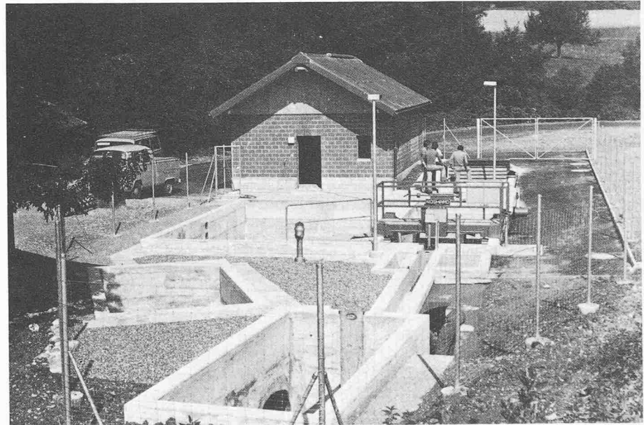
Die Anlage vor der Inbetriebnahme. Betriebsgebäude mit angebautem Faulraum. Der Estrich unter dem Satteldach dient als Geräteschopf
