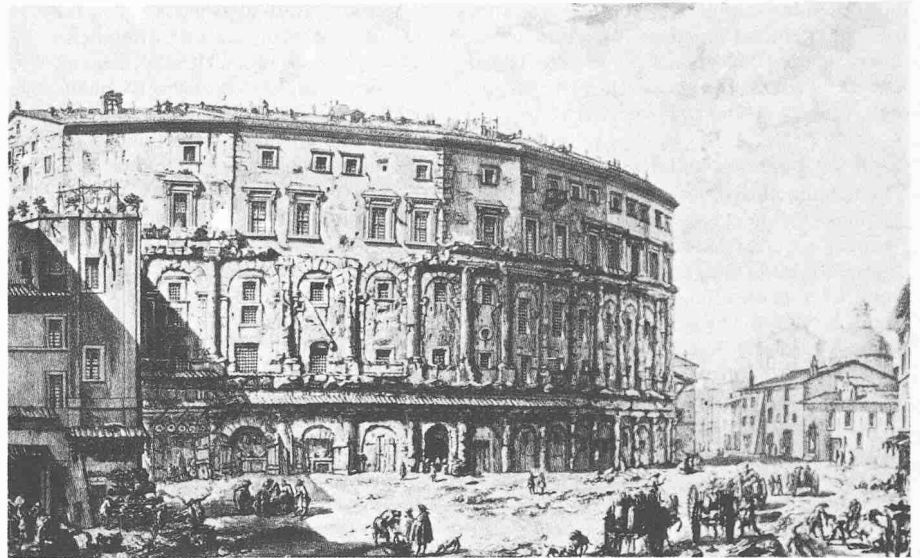
Teatro Marcello, Rom. Beispiel für die Selbstverständlichkeit, mit der die Vergangenheit mit ihrer alten Umgebung umgegangen ist. In die Ruinen des römischen Theaters wurde in der Renaissance der Palazzo Orsini ein- und aufgebaut. In der unteren Arkadenstellung richteten sich im Verlaufe der Zeit Krämer und Handwerker ein. Das 20. Jahrhundert hat in seiner restaurativ-denkmalflegerischen Haltung die Arkaden wieder freigelegt und den Bau auf das ursprüngliche Niveau ausgegraben. Das Theater hat heute die museale Ruhe eines Monumentes (Stich von Piranesi, 1757)
