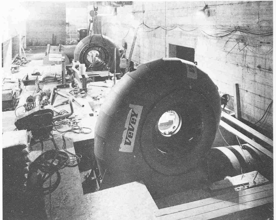
Fig. 2. Bâche spirale de la pompe réglable en cours de montage dans la centrale
