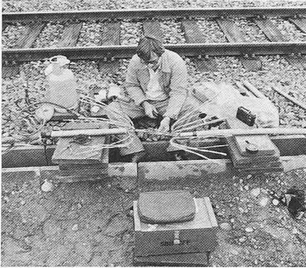
Bild 10. Kabelmonteur bei der Spleissarbeit
