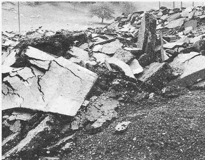
Bild 1. Deponie von Belagsaufbruch für das Recycling
